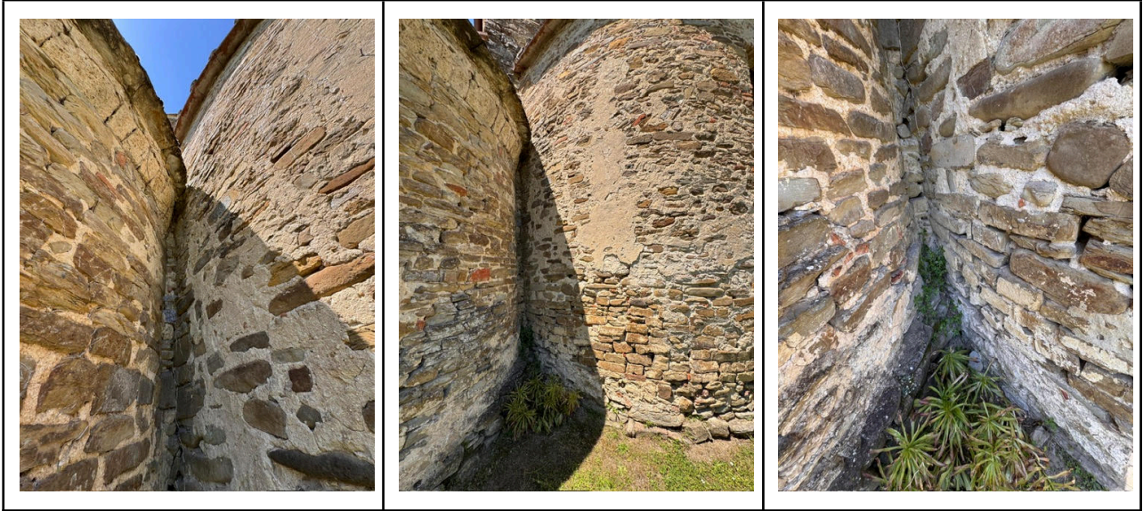
Foto 14 : particolari dell'ammorsatura dell'abside destra
