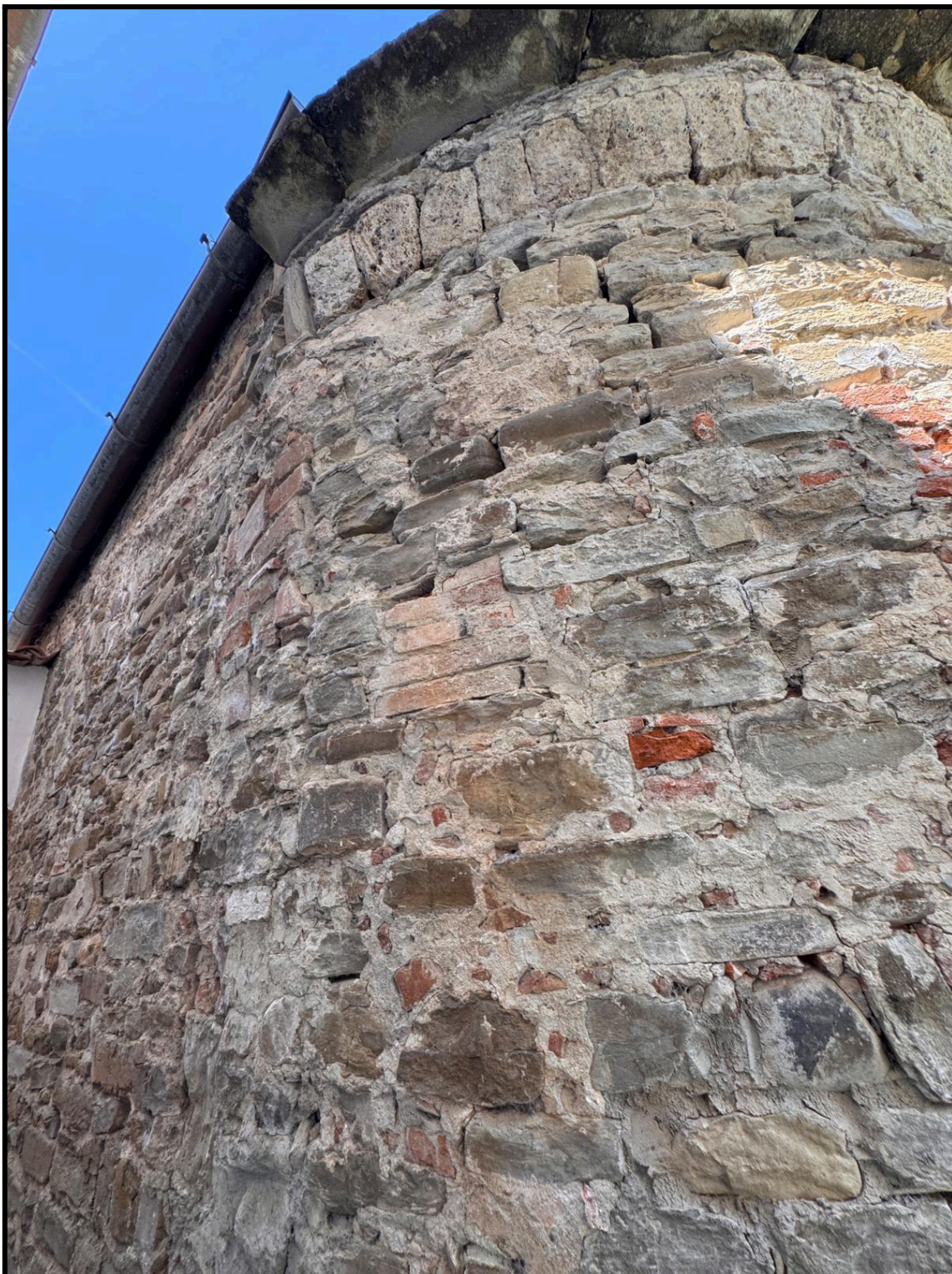
Foto 16: particolare della muratura dell'abside legata al PG sud
