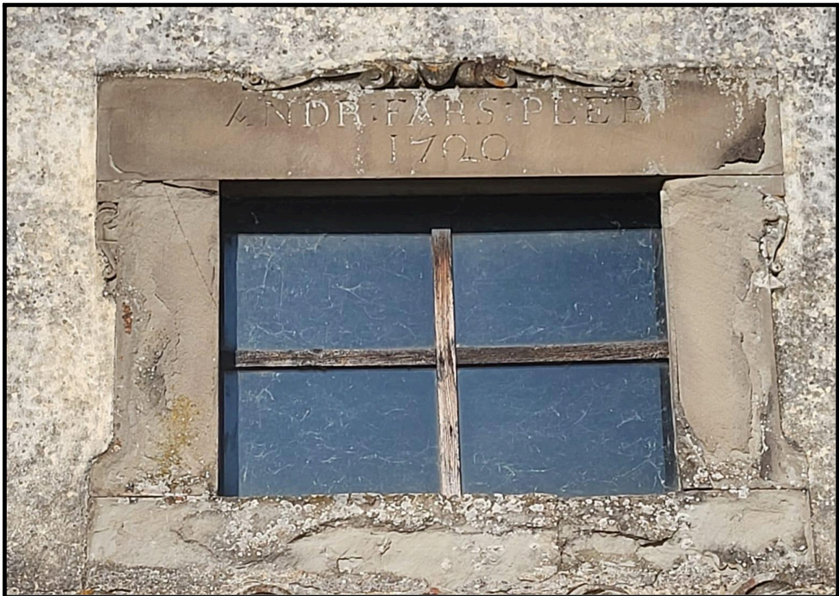
Foto 2: dettaglio della cornice superiore della finestra in facciata.
