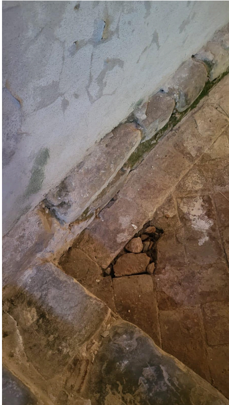
Foto 6: risega di fondazione vista dall'alto
