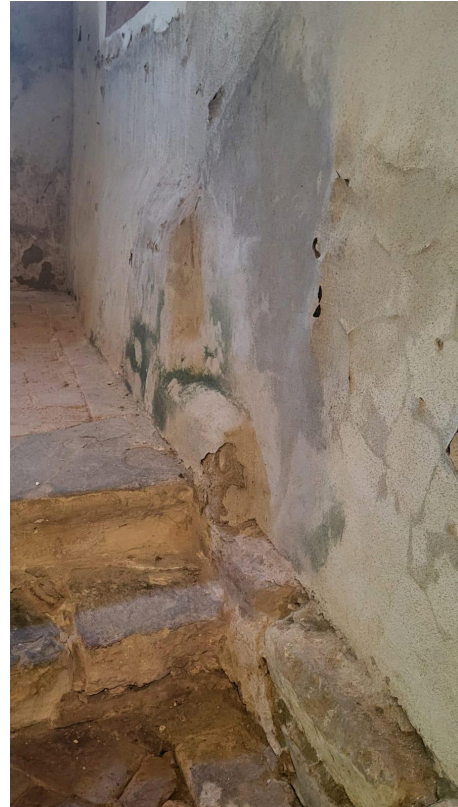
Foto 7: prospetto frontale della risega di fondazione
