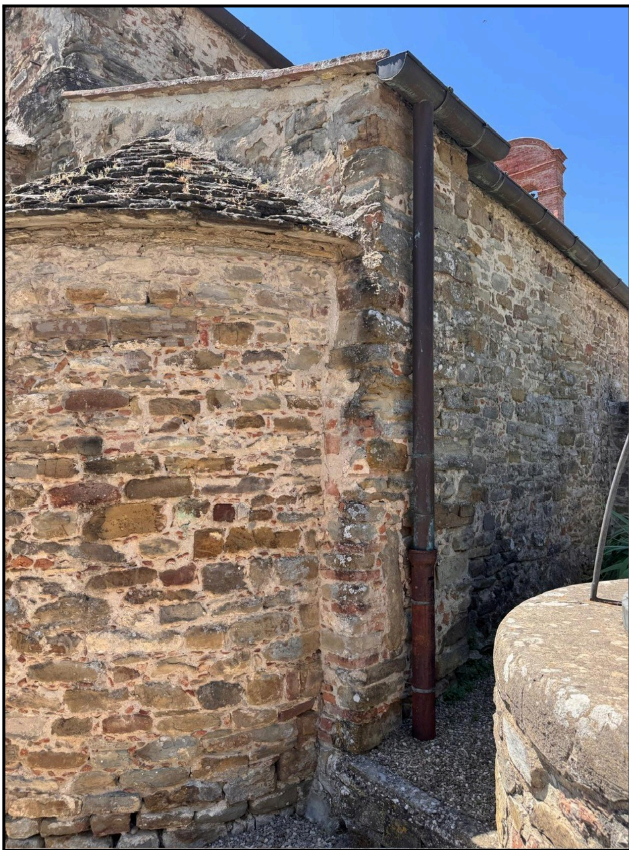
Foto 10: particolare ammorsatura dell'abside sinistra
