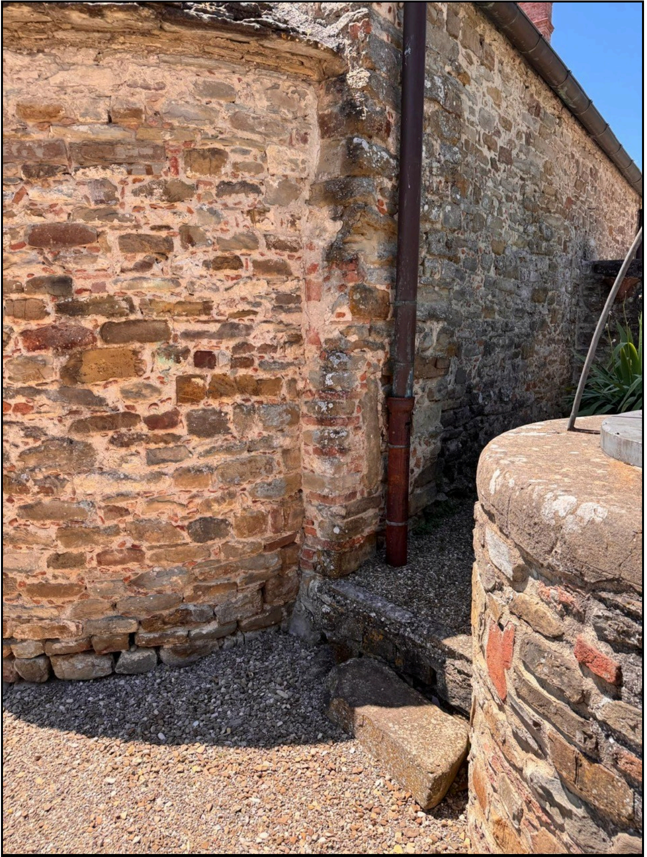
Foto 11: particolare ammorsatura dell'abside sinistra
