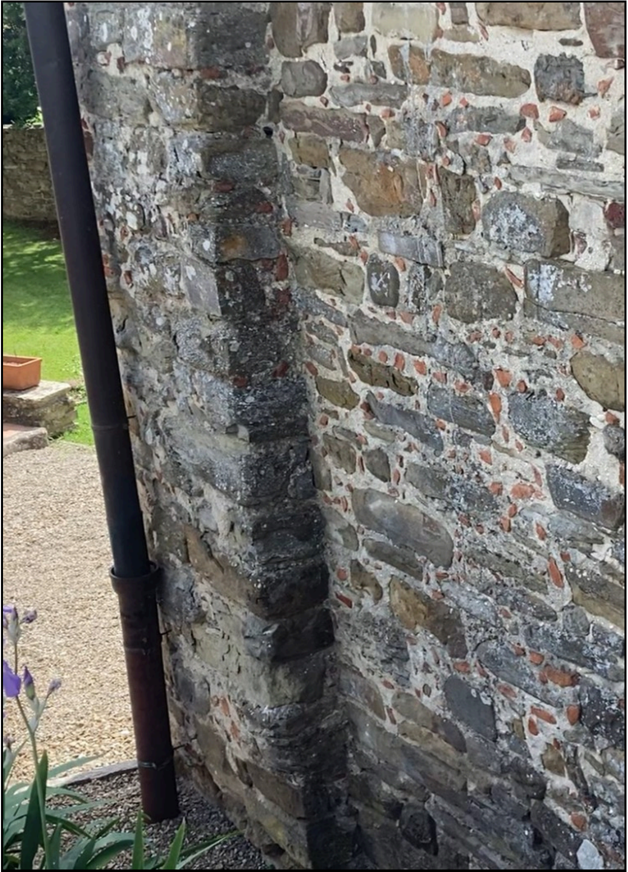
Foto 13: particolare ammorsatura dell'abside sinistra
