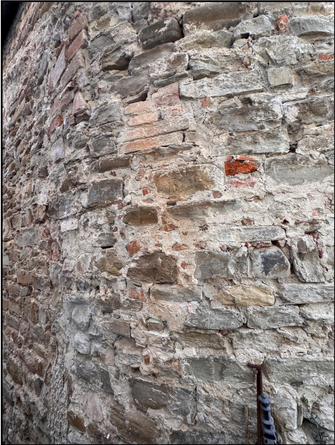
Foto 15: particolare della muratura dell'abside legata al PG sud
