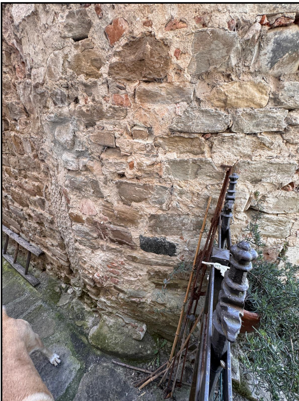
Foto 17: particolare della muratura dell'abside legata al PG sud
